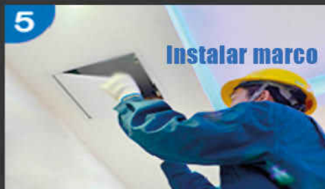
Instalar tapa de inspección
