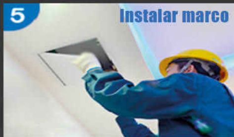
Instalar tapa de inspección
