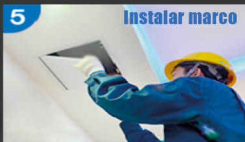
Instalar tapa de inspección
