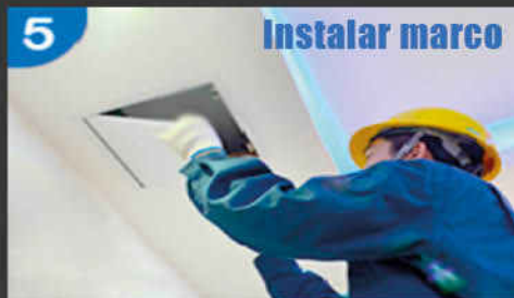
Instalar tapa de inspección
