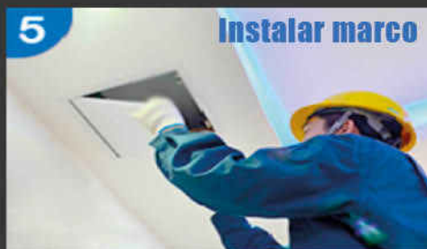
Instalar tapa de inspección
