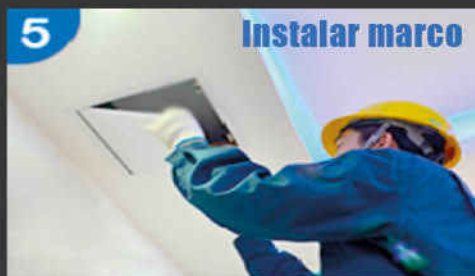
Instalar tapa de inspección
